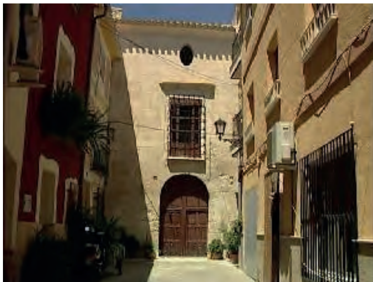
Fotografía 2. Edificio de la Encomienda. Colección particular del autor.
