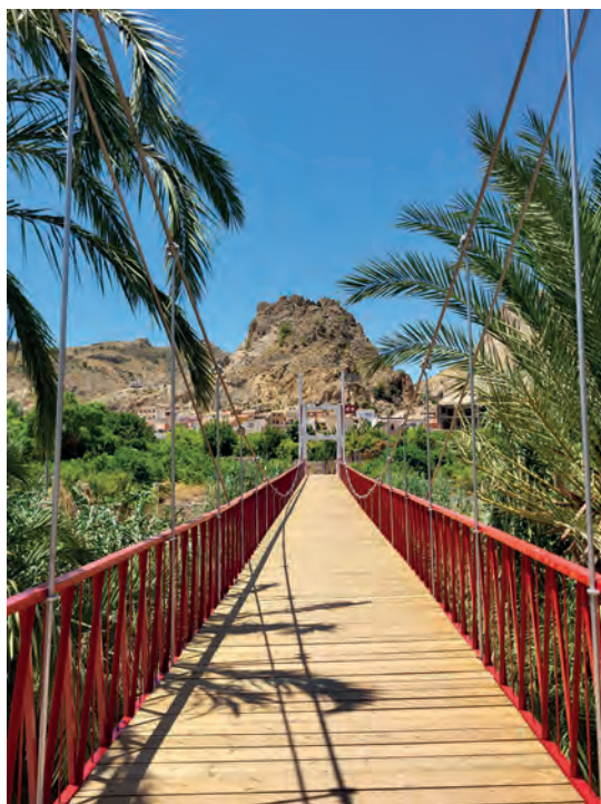
Fig. 1. Vista del Puente Cuna recientemente rehabilitado
